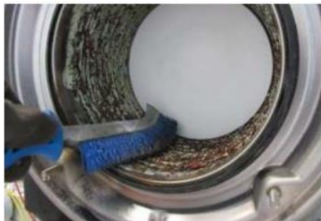
2. Очистить спирали с помощью щетки с неметаллической щетиной.
